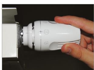
**4)** Portare la testa termostatica nella posizione di regolazione desiderata ruotando la manopola.
