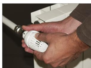
**2)** Accostare la testa termostatica alla valvola inserendola sull'esagono del corpo e avvitare la ghiera.
